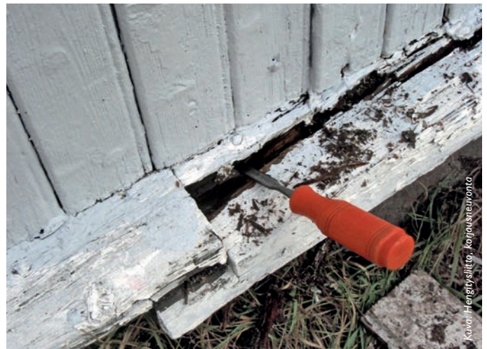
Julkisivulaudoitus ja muotolista ovat lahoja laudoituksen takaa puuttuvan tuuletusraon vuoksi.
