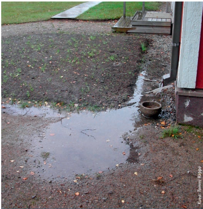
Vedenpoisto talon nurkalta ei toimi.
