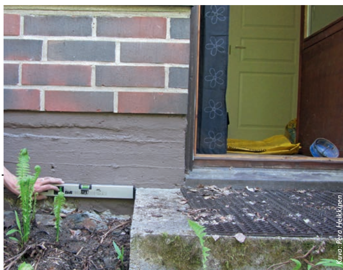
Kun ulko-oven alareuna on selvästi alempana kuin sokkelin yläreuna, on kyseessä valesokkeli.
