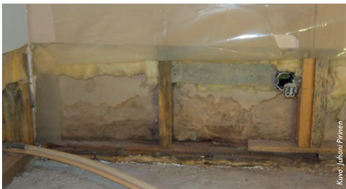
Alajuoksuvaurio on tyypillinen vika, joka havaitaan vasta kun rakenteita avataan.
