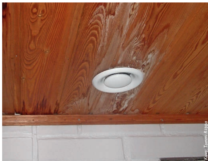
Huonosti eristettyyn ilmanvaihdon poistoputkeen on tiivistynyt vettä, joka on kastellut rakenteita.
